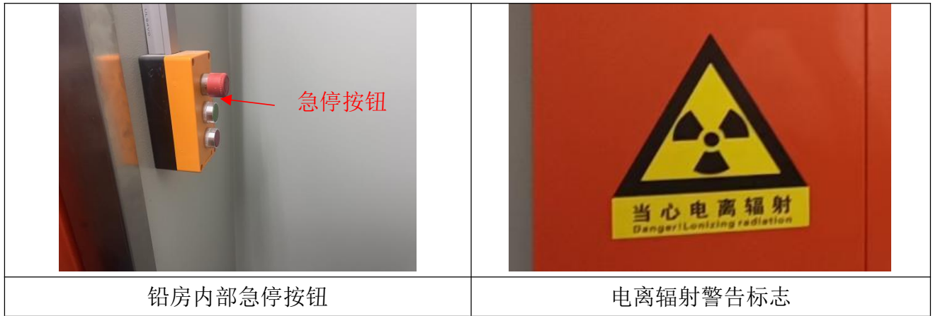
图 2-5 现场调查照片
